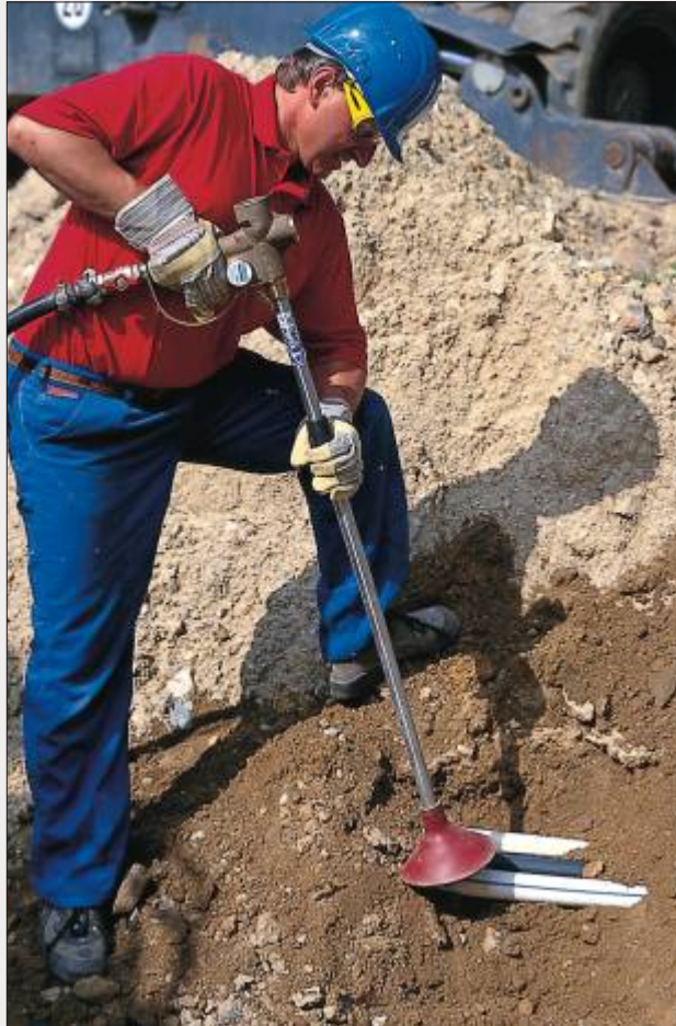
Versorgungsleitungen freilegen
