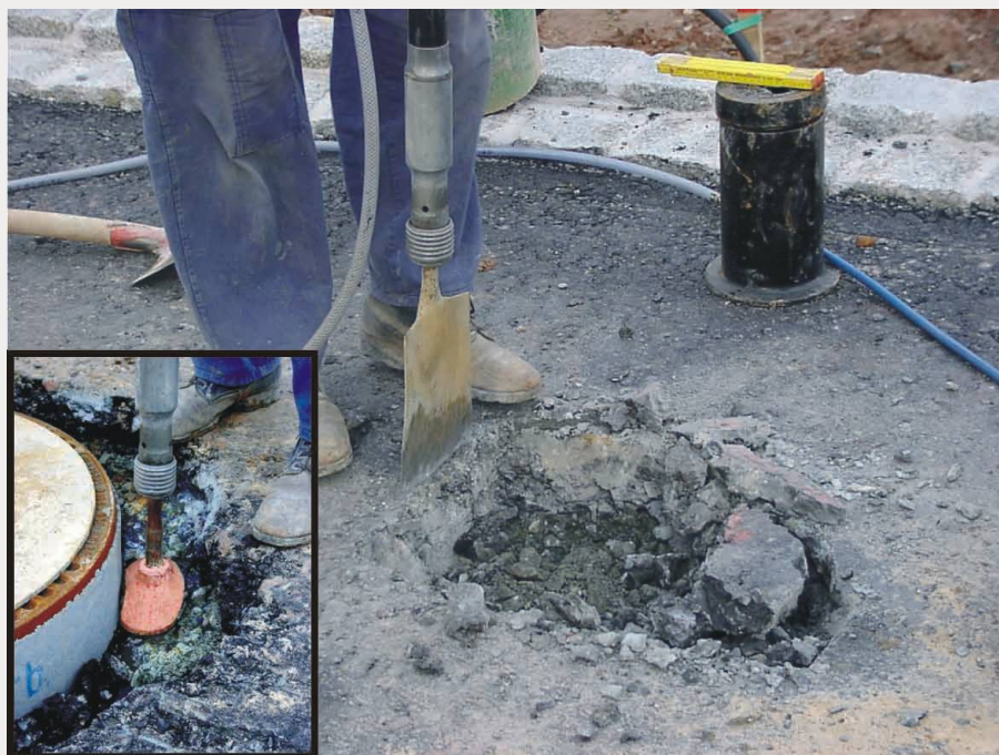
Eine hohe Schlagkraft bei nur 6 kg Eigengewicht und eine große Werkzeugauswahl macht den Vogt-Turbo-Spaten zum kleinen Partner von großen Maschinen. Foto: Vogt Baugeräte
