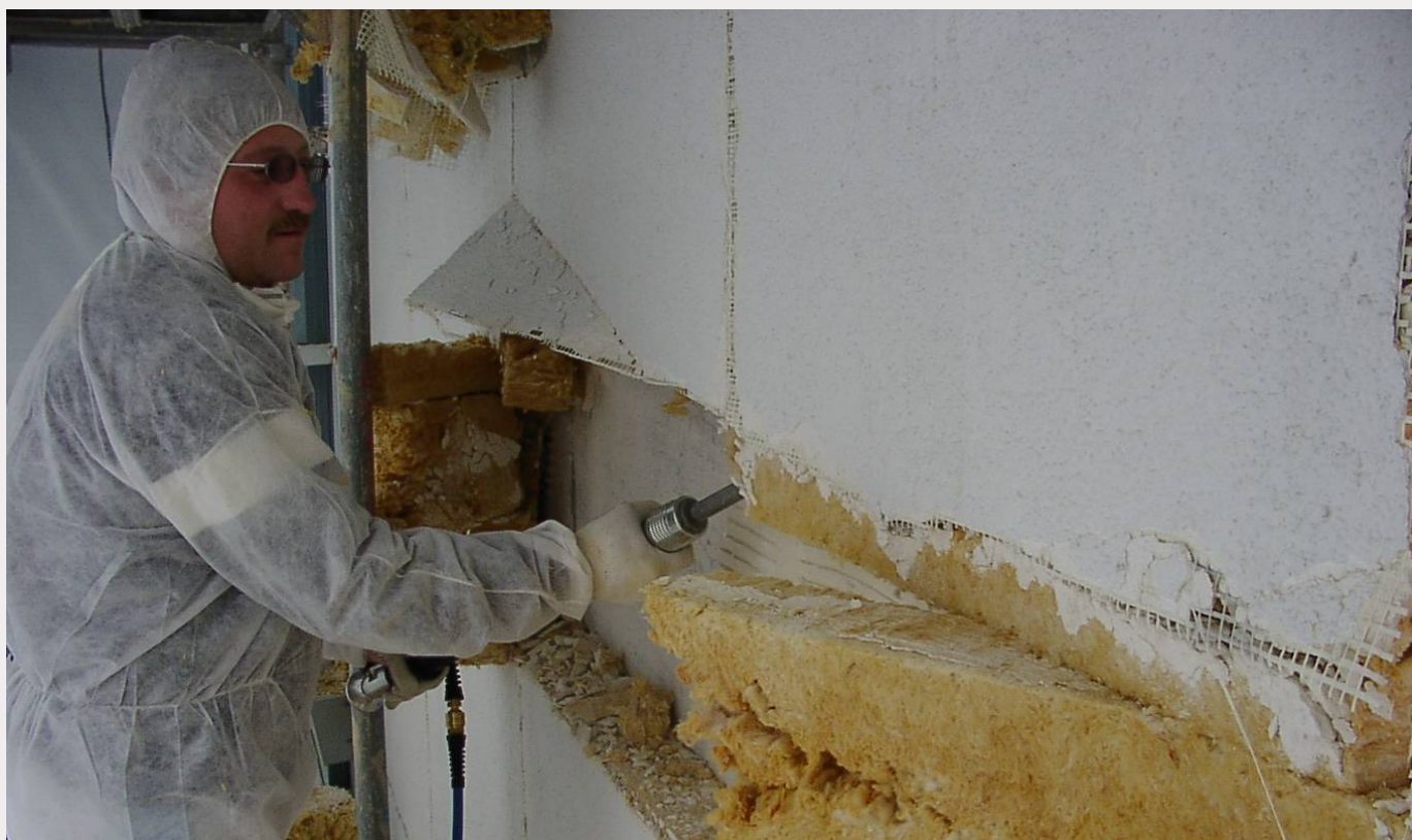
Vogt Baugeräte bietet eine Vielzahl an Produkten. Mit den Federstahl-Schabern beispielsweise ist es möglich, Innenputz auf glattem Untergrund zügig zu entfernen, Beschichtungen sowie Dünnputze abzuschaben oder auch vertrocknet aufgebrachten Oberputz auf WDVS abzutragen, ohne das Armiergewebe zu zerschneiden. Auch Dämmstoffe lassen sich gut lösen.
