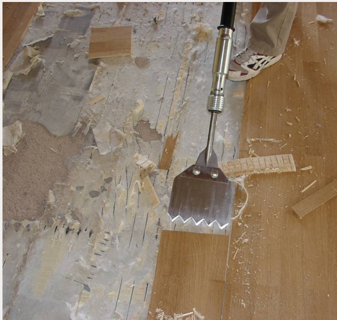
Auch elastisch verklebtes Parkett lässt sich mit dem Vogt-Hammer entfernen.
